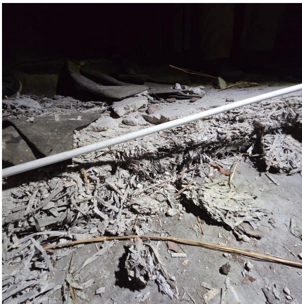
Fot. 10 Widok ocieplenia stropu II-ej kondygnacji od strony strychu wykonane z supremy
