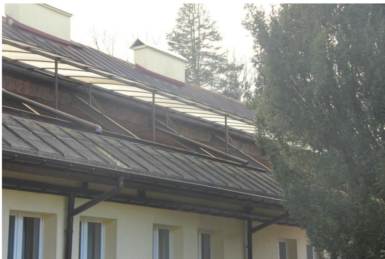
Fot.5 Połąć dachowa wraz z daszkami z poliwęglanu
