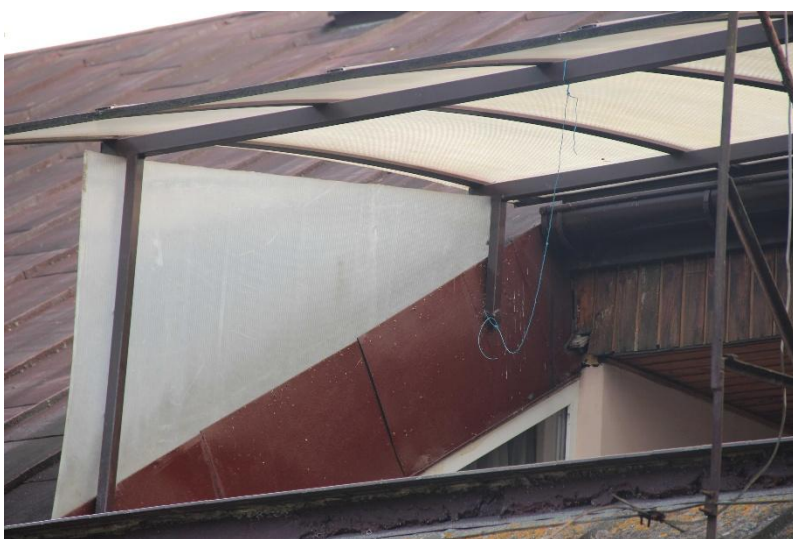
Fot.6 Konstrukcja stalowa dla daszków z poliwęglanu
